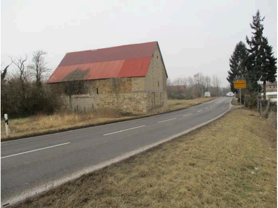
Die Scheune »Leisenheimer« kurz vor dem Abriss im Februar 2017
